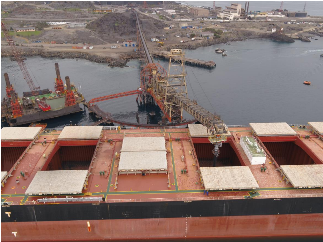
Figura: Cargadores de barcos con vigas verticales y operación de carga continua.
